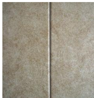
↑ Fini vertical sans moulure apparente
