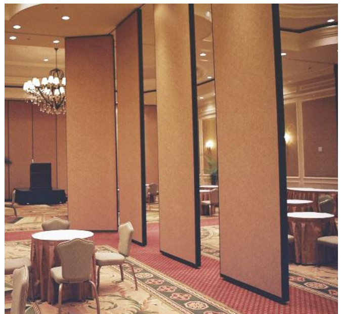
↑ Fini vertical sans moulure apparente
